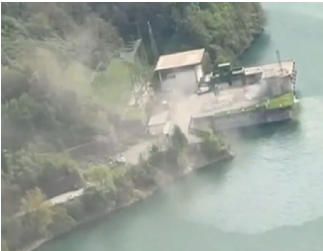
ESPLOSIONE ALLA CENTRALE IDROELETTRICA DI BARGI (SUVIANA)
